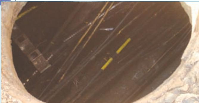
**Рис.5** Микроволоконная система, проложенная в старой канализации
