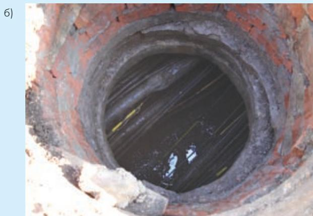
Рис. 2 Типичное состояние колодцев: засыпаны землей (а) и требуют капитального ремонта (б)
